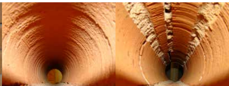
particolari dell'interno dei perfori nella muratura
