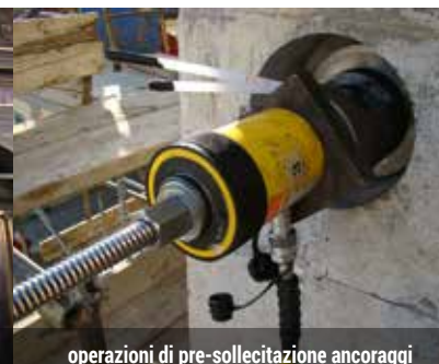
operazioni di pre-sollecitazione ancoraggi
