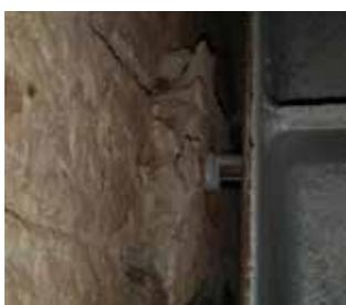
TECNICA E MATERIALI\_Impiego di ancoraggi a iniezione controllata con calza costituiti da **barra in acciaio inossidabile ad alta resistenza diametro 12 mm (GBOS 12/304)** inserite in **perfori diametro 30 mm** in corrispondenza del lato corto del pilastro (lung. max. 2,60 m) e **40 mm** in corrispondenza del lato lungo del pilastro (lung. max. 4,20 m).
