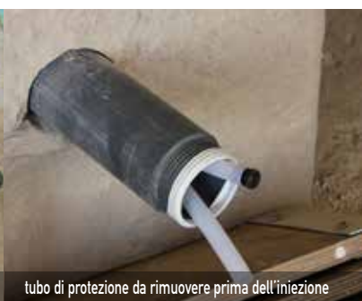
inserimento ancoraggio all'interno del tubo di protezione
