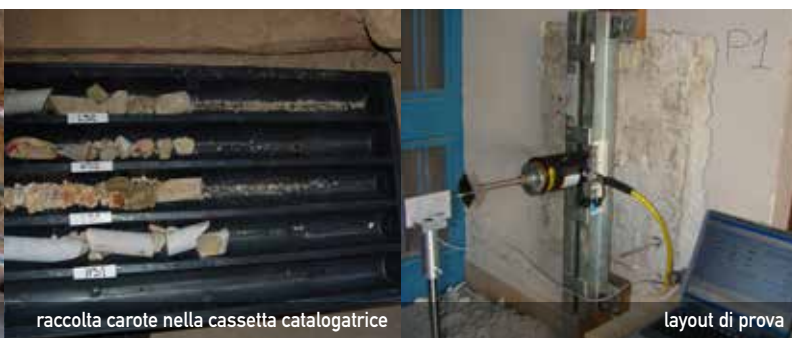
perforazioni per sede ancoraggio test
